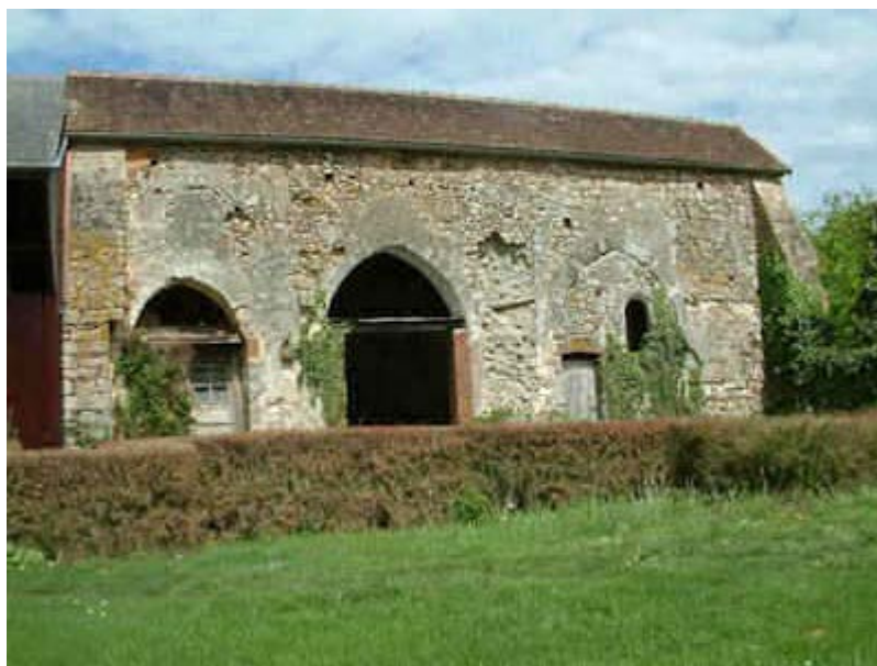
Vestiges de la chapelle de Coulours
